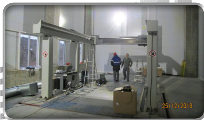
Проектирование, строительство, устройство высокоточных фундаментов, монтаж и подключение измерительной машины Alpha image 255015/205 по адресу: Москва, ул. Автозаводская, дом 23, стр. 82. Застройщик ООО «ААТ»
