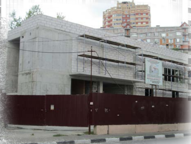
Стадия: ведётся строительство. 2014г.
