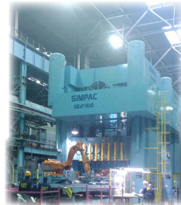
Техническое перевооружение. Линия штамповки ТАНДЕМ для ООО «Альфа Автоматив Техноложиз». Москва. 2010 г.
