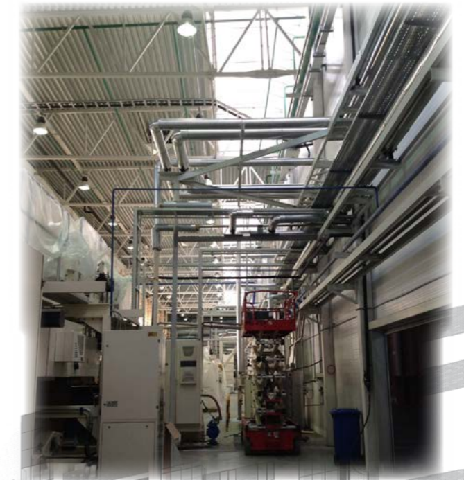
Технологические трубопроводы на предприятии по производству гофрокартона для ОАО «Архбум». Московская область. 2012 год.
