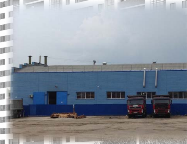
Разработка проектной документации, ввод в эксплуатацию реконструкции зданий цеха для производства сварочных и цеха механосборочных работ для ООО «Гидроаэроцентр». Объект введен в эксплуатацию. 2013 год.
