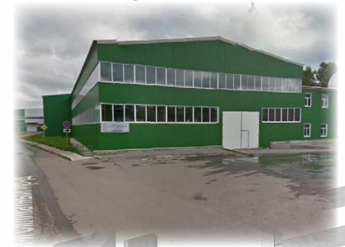
Реконструкция производственных цехов (I и II очередь) Мытищинского приборостроительного завода ОАО «МПЗ». Объект введен в эксплуатацию в 2009 году.
