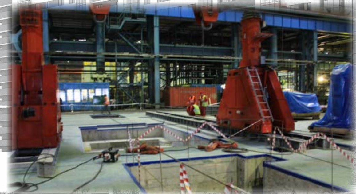
Проектирование и строительство фундаментов под технологическое оборудование линии раскроя металла 500Т для ООО «Альфа Автоматив Техноложиз». Москва. 2013 год.
